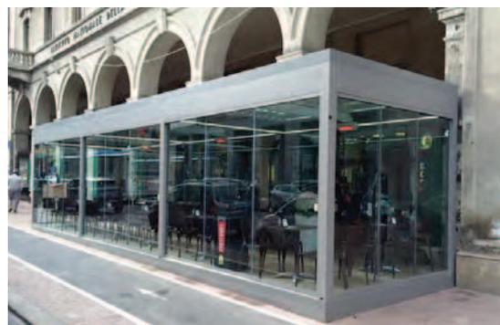
DESCRIZIONE: dehor con parete in aderenza alla relativa attività commerciale. Modulo a pianta rettangolare realizzato con struttura in metallo colore grigio e tamponature in vetro trasparente; copertura piana. La struttura è rialzata su pedana in legno.
