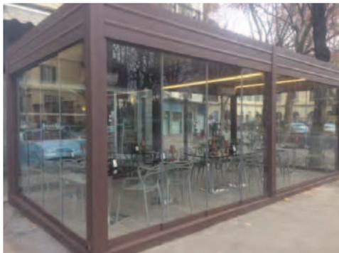
DESCRIZIONE: dehor con parete in aderenza alla relativa attività commerciale. Modulo a pianta rettangolare realizzato con struttura in metallo colore marrone e tamponature in vetro trasparente; copertura ad una falda. La struttura è rialzata su pedana in legno.
