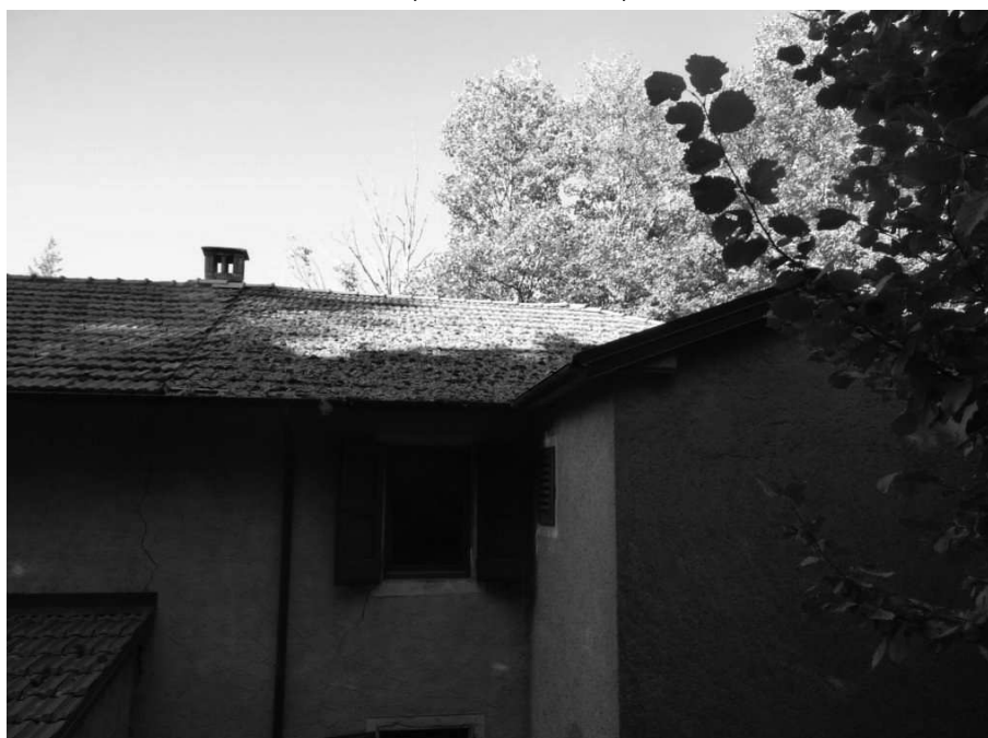
Foto 22 - particolare della copertura
