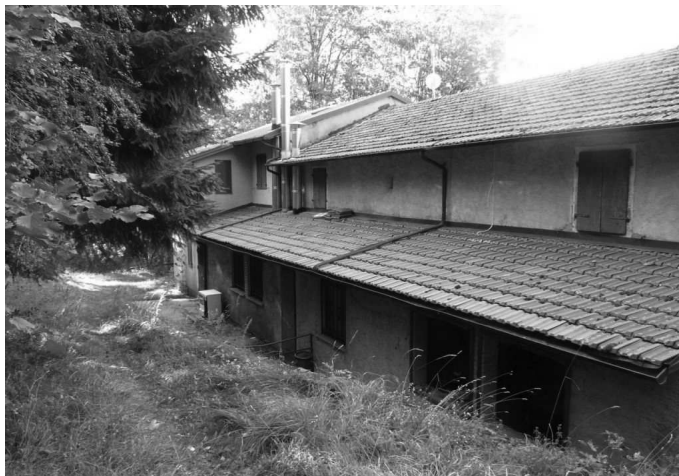
Foto 8 - ampliamento prospetto tergale
