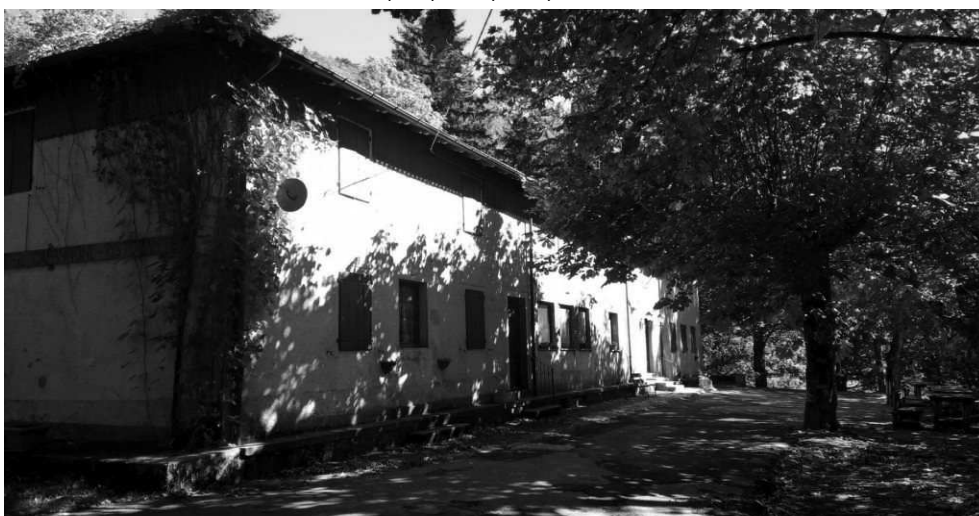
Foto 3 - prospetto principale (da ovest)
